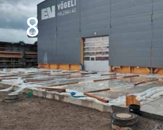
Baustelle Vögeli Holzbau © 2024 Sandro Fischer
