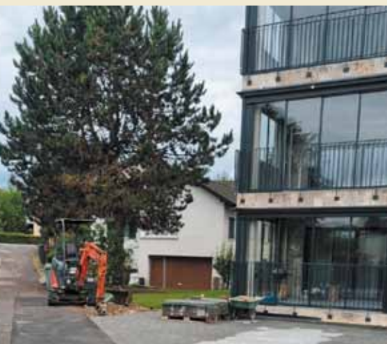
Baustelle Querstrasse © 2024 Sandro Fischer
