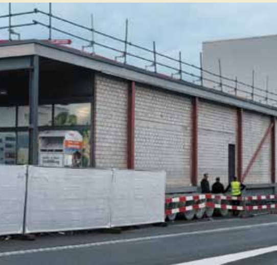
Baustelle Coop © 2024 Sandro Fischer
