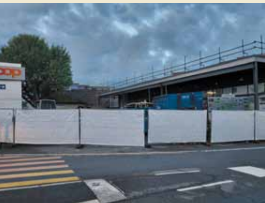
Baustelle Coop © 2024 Sandro Fischer
