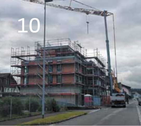
Rohbau Stauseestrasse © 2024 Sandro Fischer
